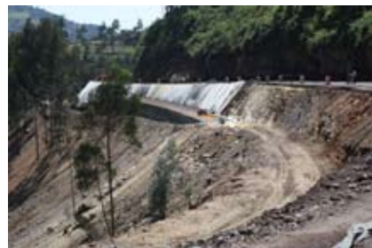
Rwanda har hatt en voldsom utvikling under Kagame. Her fra byggingen av ny vei mellom Kigali og Gisenyi.
